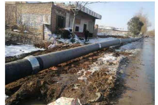
非开挖系列——拖拉管
